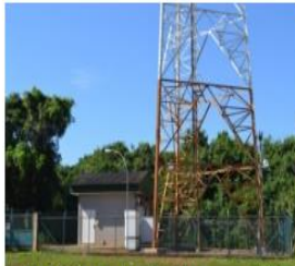
A vítima fazia manutenção da torre com mais três colegas, quando sofreu a queda. (Foto: Guilherme Henri)
